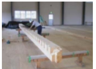
写真11: 宮大工による木材加工事例
