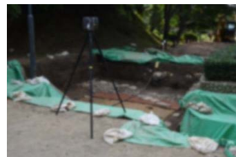
3次元測量器による石垣の計測
